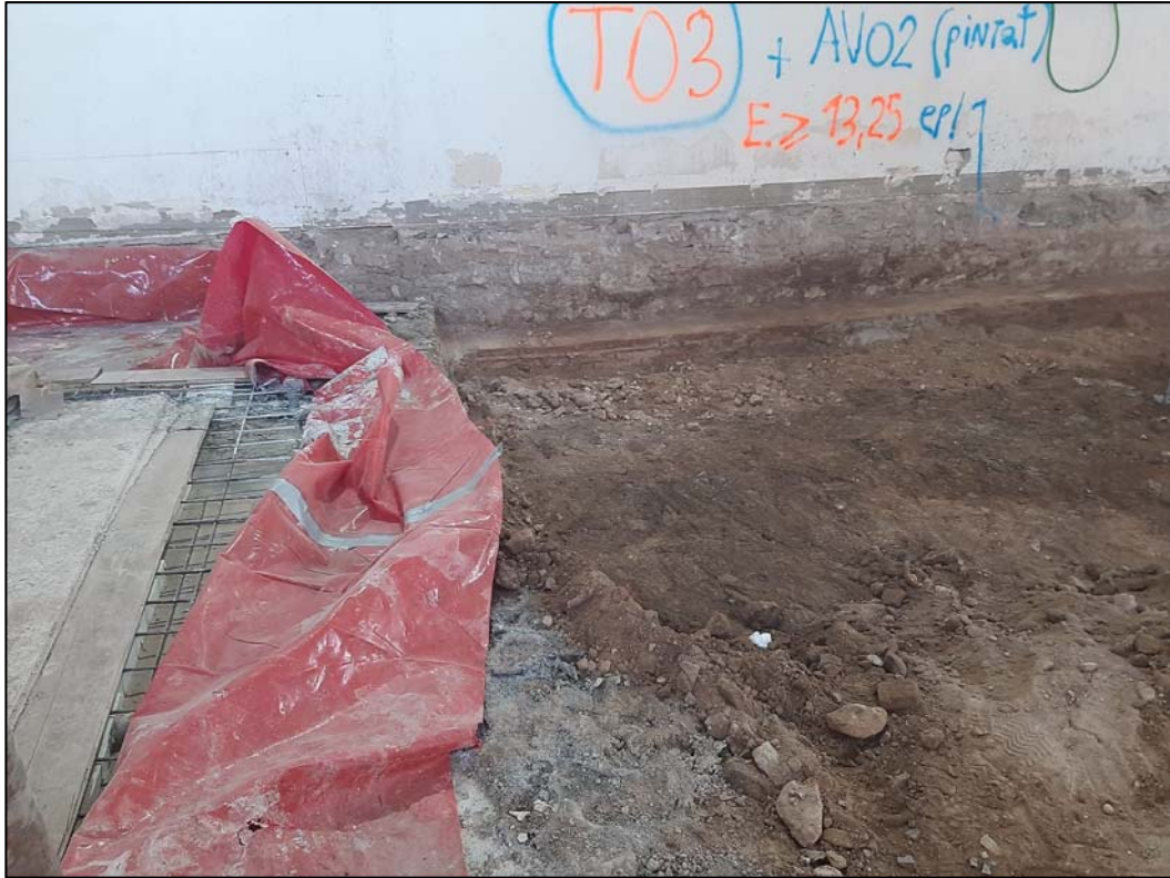
7. Actuacions de rebaix de l'ala nord de la planta baixa.
