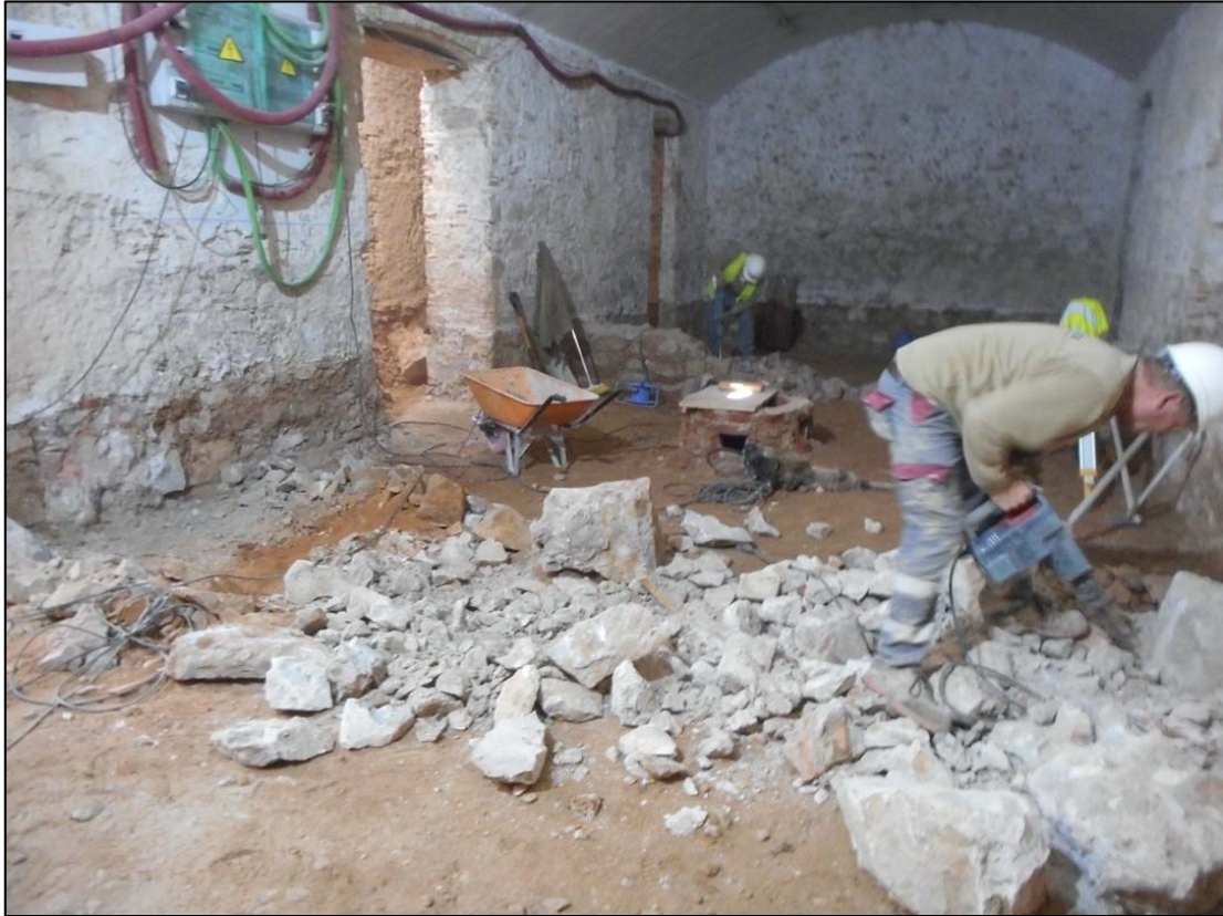
67. Treballs d'enderroc dels primers 60cm de les estructures documentades. Àmbit B UE105-106.
