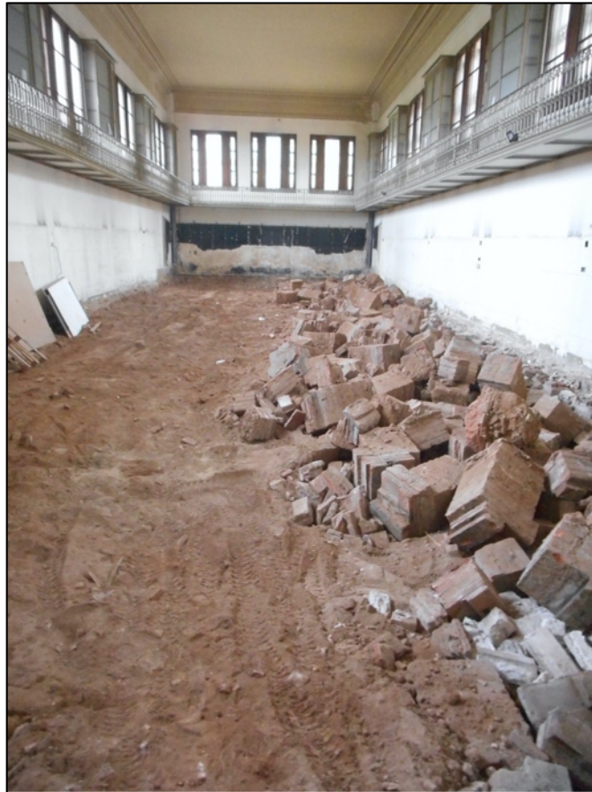
11. Actuacions de rebaix de l'ala sud de la planta baixa.
