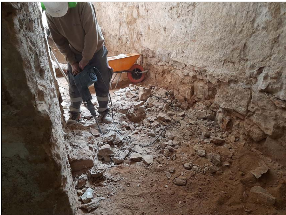
72. Treballs d'enderroc dels primers 60cm de les estructures documentades. Àmbit C UE106.
