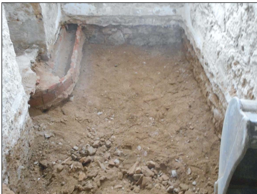
22. Localització d'un traçat de clavegueram UE104, àmbit A.
