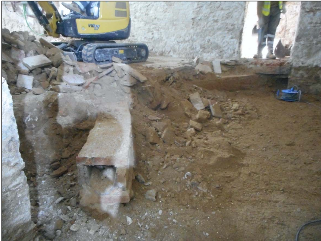
27. Tasques de rebaix general a la planta soterrani, àmbit B.
