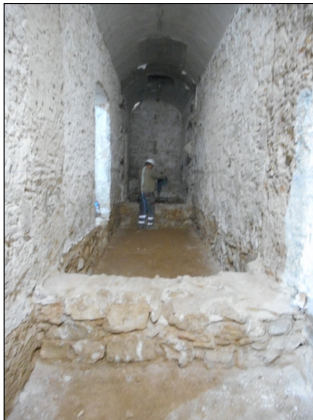
74. Treballs d'enderroc dels primers 60cm de les estructures documentades. Àmbit A UE's 105-106.
