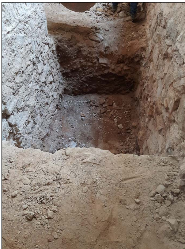
61. Àmbit C. Tasques de realització del fossat de l'ascensor, final.
