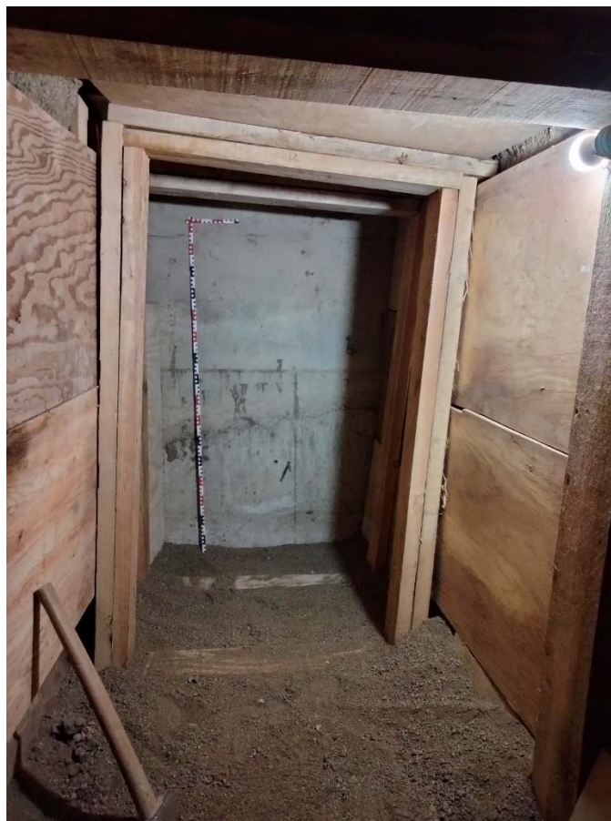
123. Final de l'excavació de la Mina 2 amb la paret del col·lector al fons.
