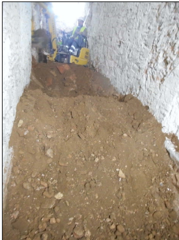
24. Inici de les tasques de rebaix general a la planta sotterrani, extracció de la pavimentació actual UE101.
