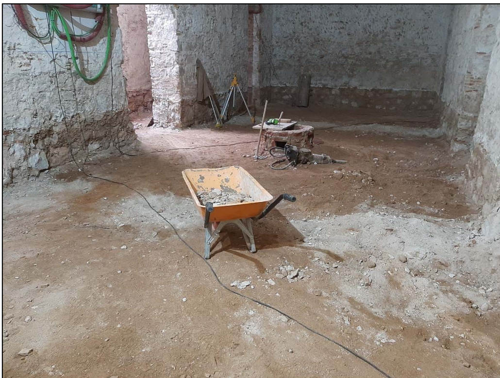
70. Treballs d'enderroc dels primers 60cm de les estructures documentades. Àmbit B UE105-106.
