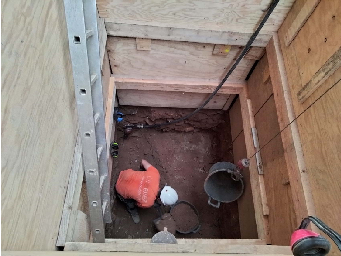
125. Procés d'excavació del Pou 3.
