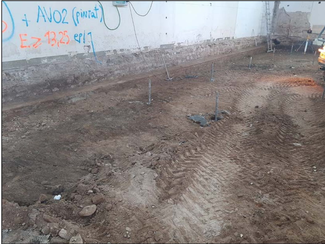
5. Actuacions de rebaix de l'ala nord de la planta baixa.
