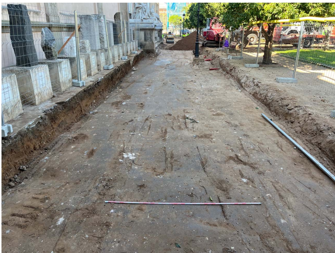
112.Excavació finalitzada de la fonamentació de la rampa d'accés a l'edifici.
