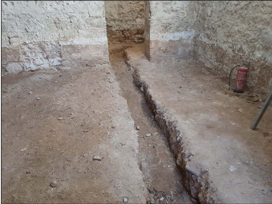
65. Àmbit B. Tasques de realització de les rases per al nou sistema de sanejament.
