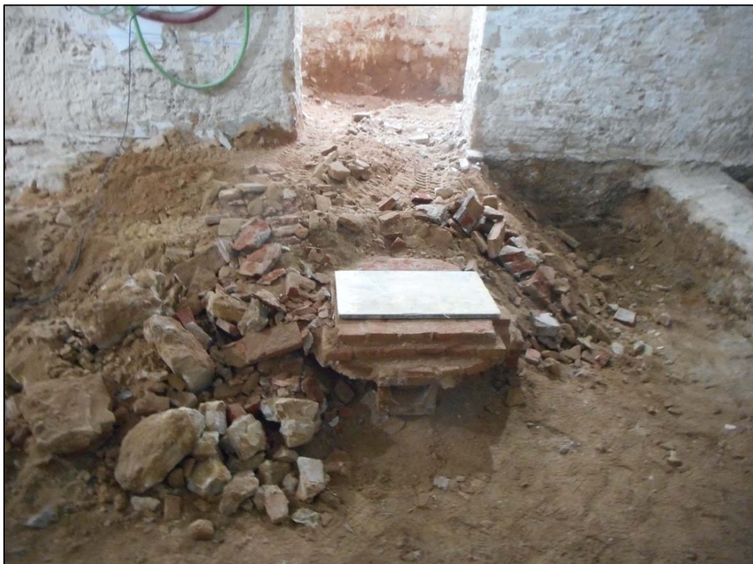
28. Tasques de rebaix general a la planta soterrani, àmbit B.
