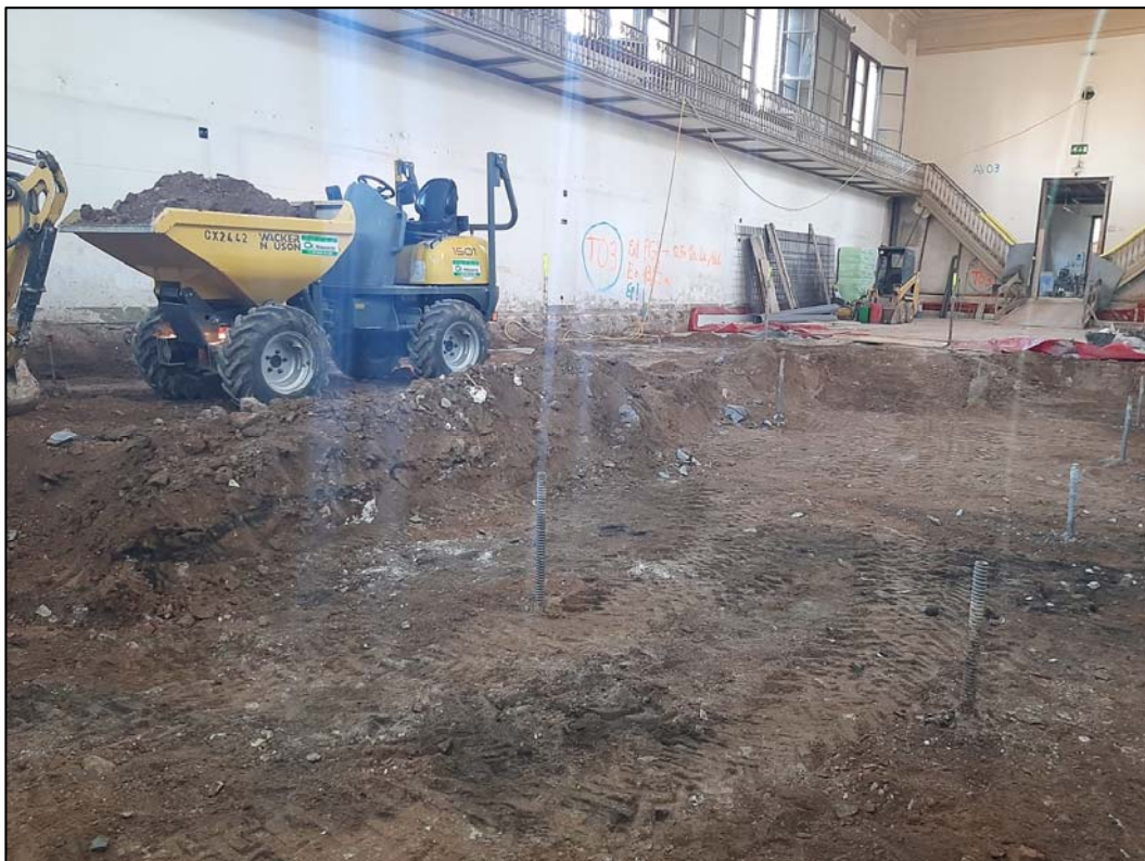
4. Actuacions de rebaix de l'ala nord a la planta baixa.
