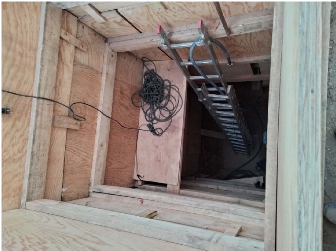
126. Final d'excavació i entaulament del Pou 3.
