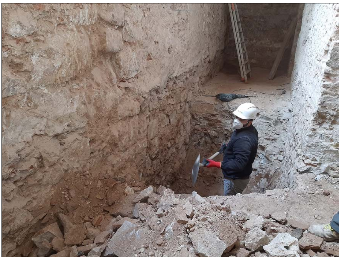
60. Àmbit C. Tasques de realització del fossat de l'ascensor.
