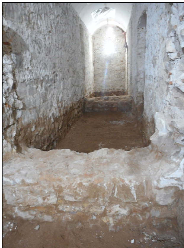
35. Àmbit A, final de les tasques de rebaix. En primer terme UE106.
