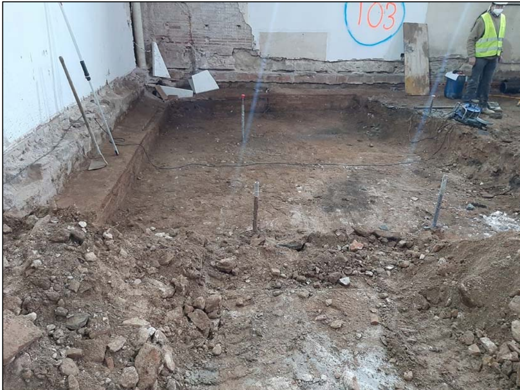
1. Actuacions de rebaix de l'ala nord de la planta baixa.
