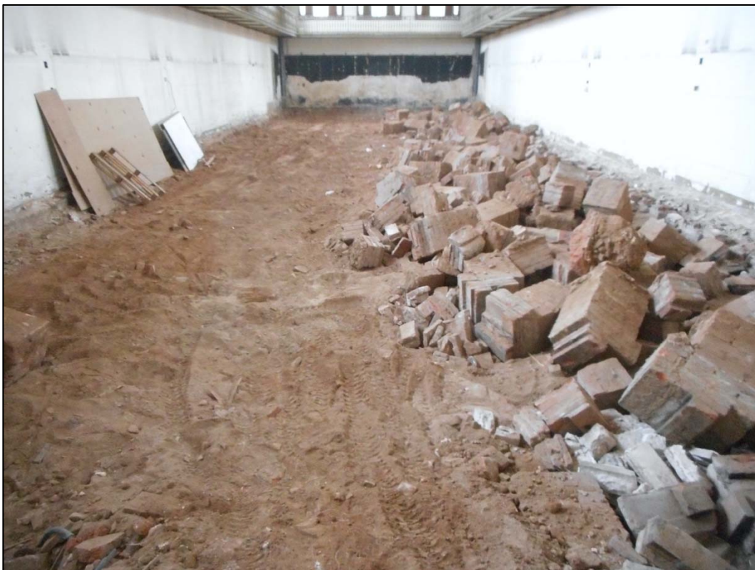
10. Actuacions de rebaix de l'ala sud de la planta baixa.
