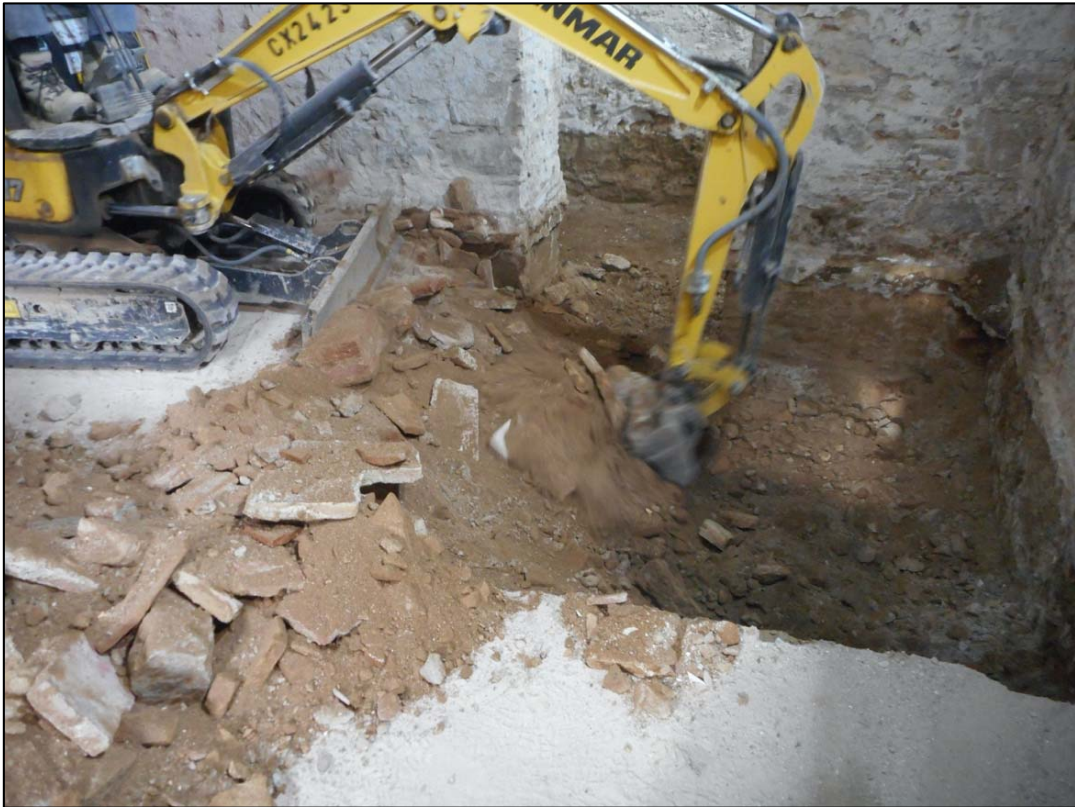
25. Tasques de rebaix general a la planta soterrani, àmbit B.
