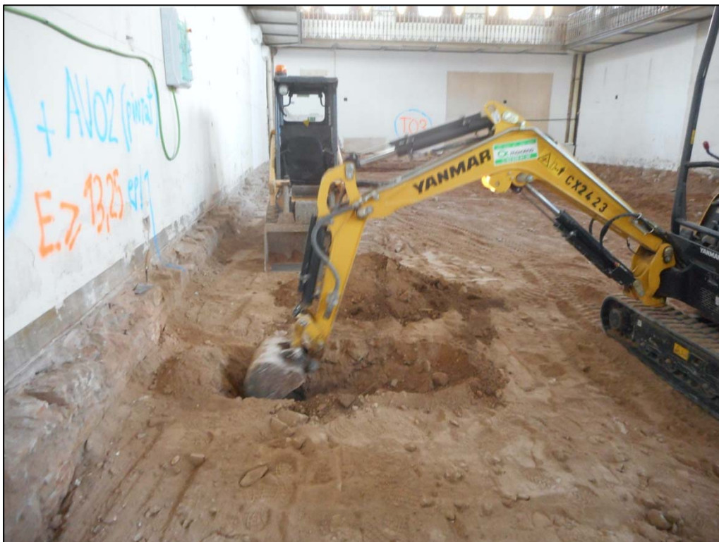
14. Cala de sondeig a l'ala nord de la planta baixa.
