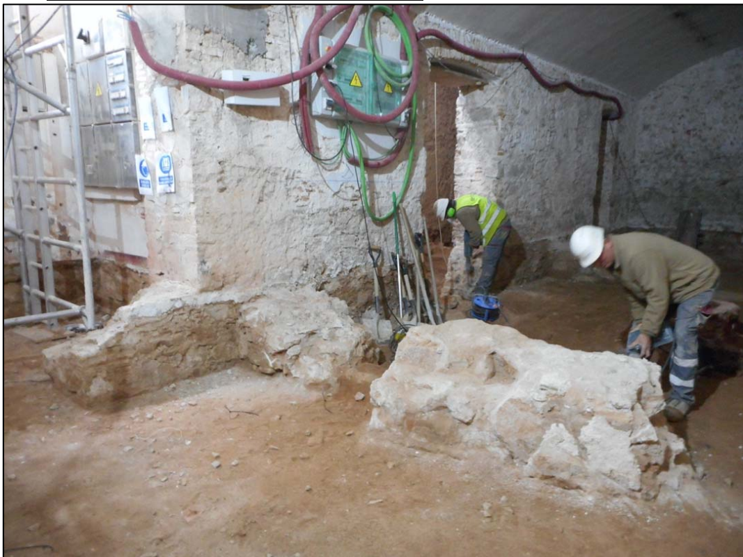
66. Treballs d'enderroc dels primers 60cm de les estructures documentades. Àmbit B UE105.
