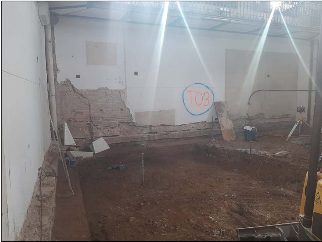
3. Actuacions de rebaix de l'ala nord a la planta baixa.
