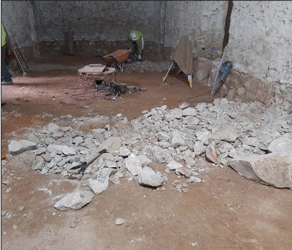
69. Treballs d'enderroc dels primers 60cm de les estructures documentades. Àmbit B UE105-106.
