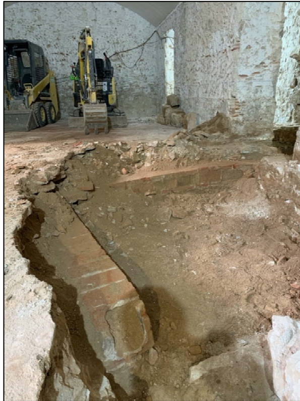
51. Àmbit B, xarxa de clavegueram UE104-108.
