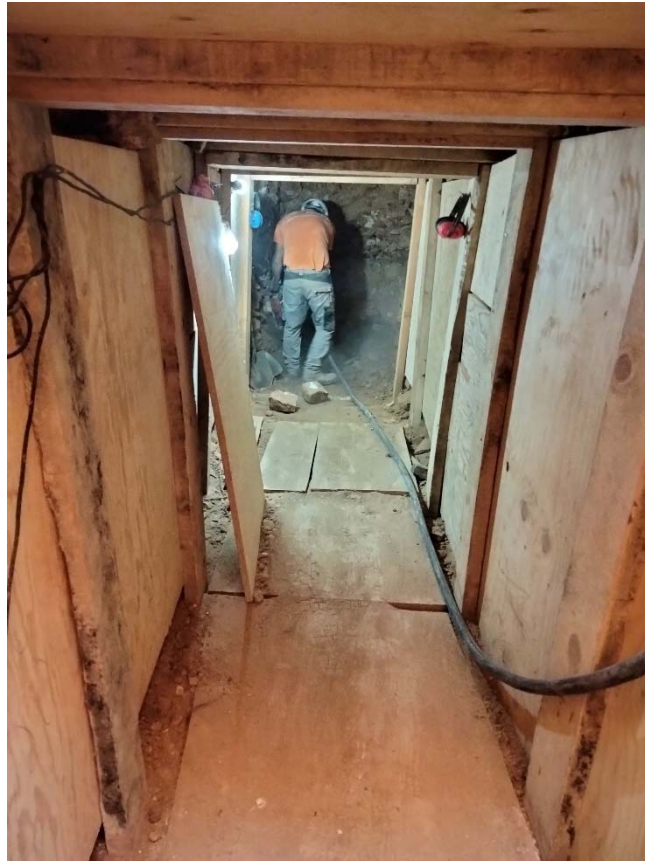
127. Excavació de la Mina 1.
