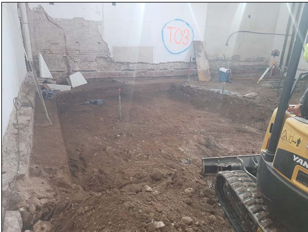
2. Actuacions de rebaix de l'ala nord de la planta baixa.
