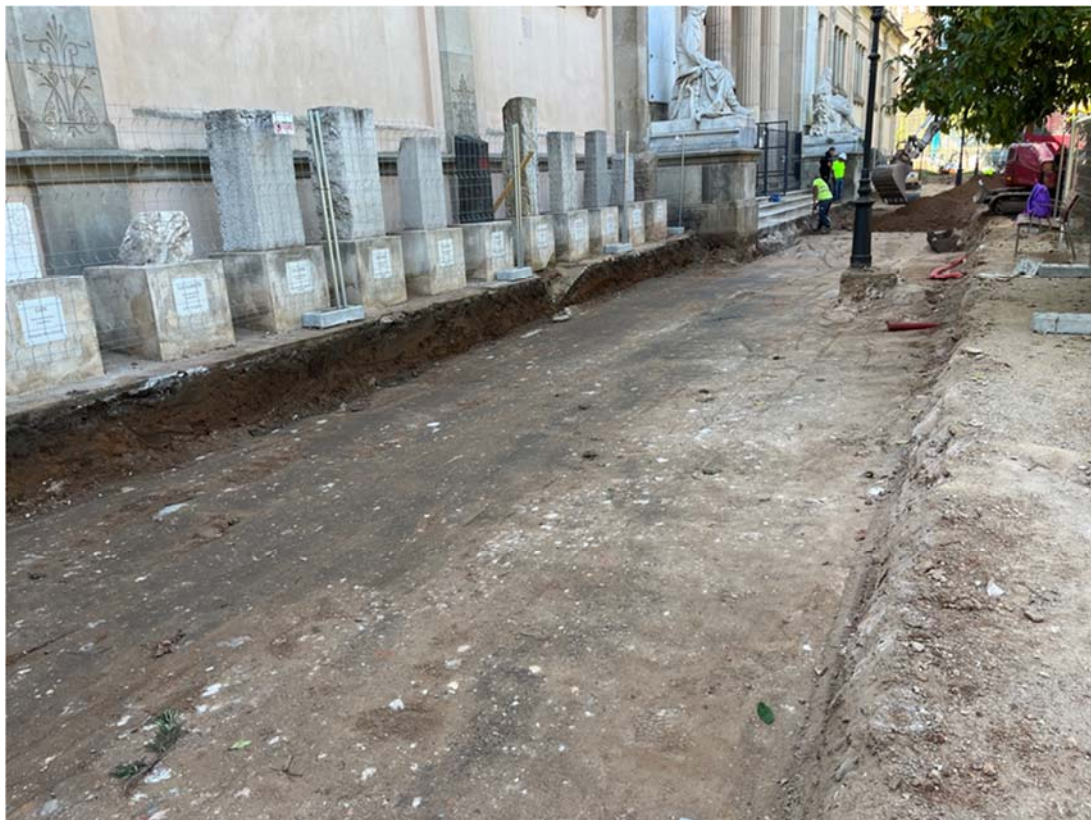
111. Excavació realitzada per a la fonamentació de la rampa d'accés a l'edifici
