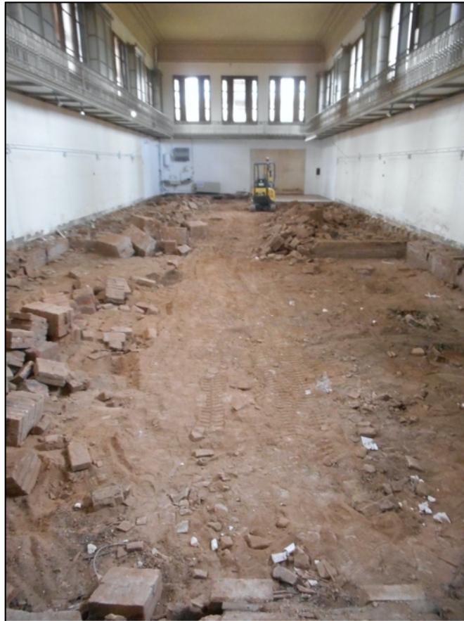
13. Actuacions de rebaix de l'ala sud de la planta baixa.
