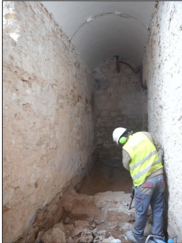
71. Treballs d'enderroc dels primers 60cm de les estructures documentades. Àmbit C UE106.
