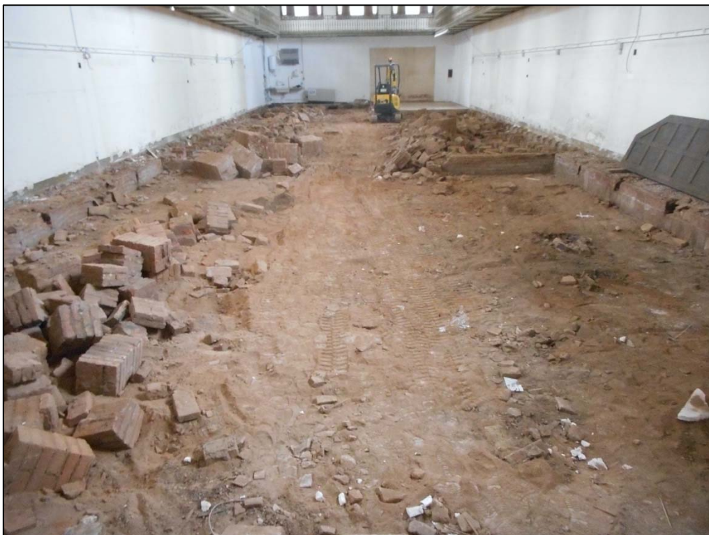
12. Actuacions de rebaix de l'ala sud de la planta baixa.
