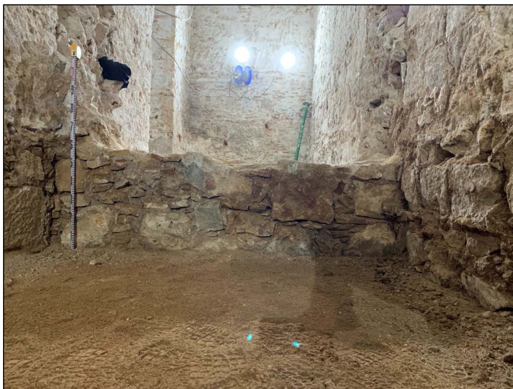
36. Àmbit A, final de les tasques de rebaix. Alçat sud UE106.
