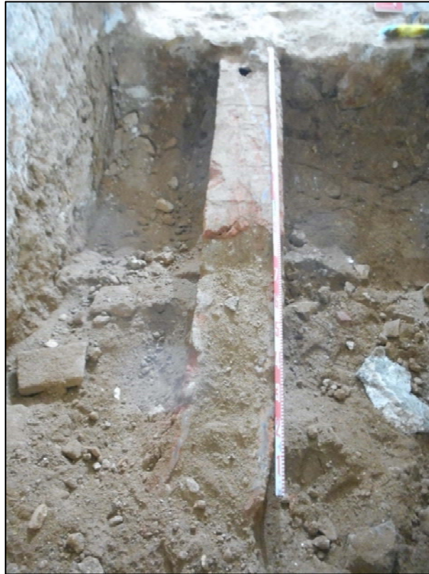
23. Localització d'un traçat de clavegueram UE108, àmbit A.
