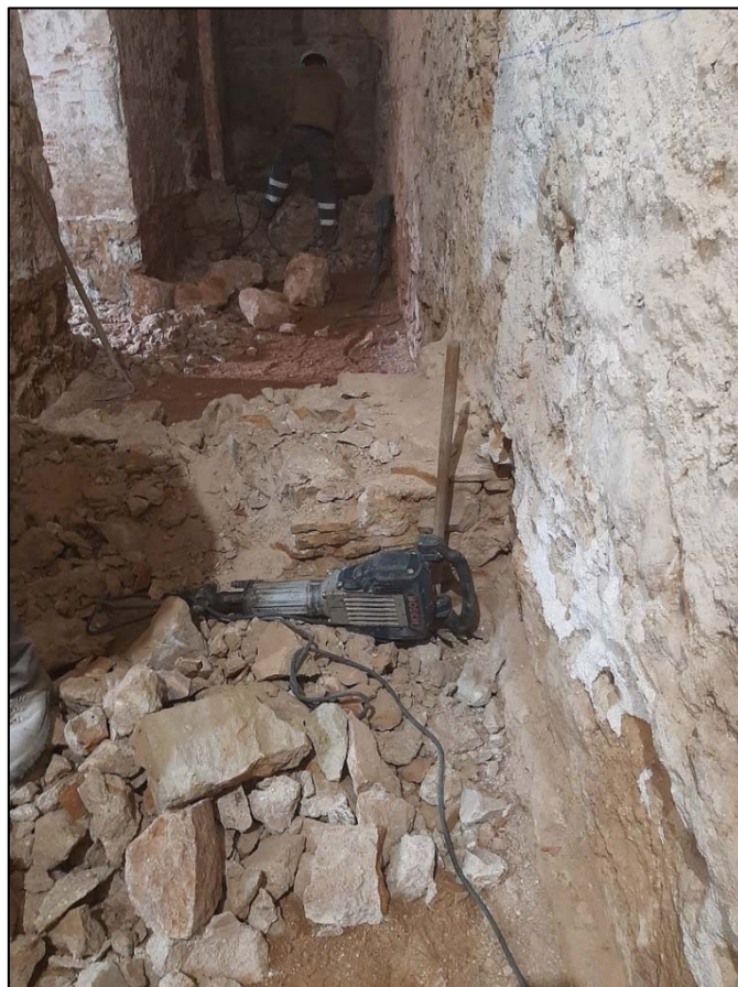
77. Treballs d'enderroc dels primers 60cm de les estructures documentades. Àmbit A UE 105-106.
