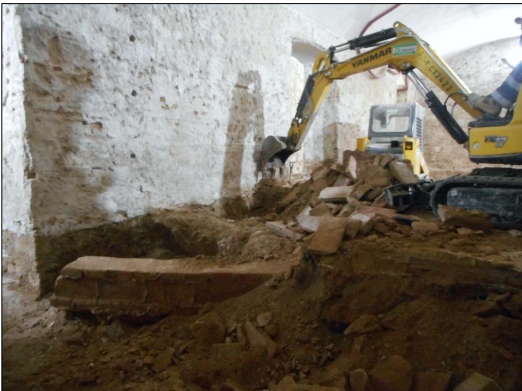
26. Tasques de rebaix general a la planta soterrani, àmbit B.
