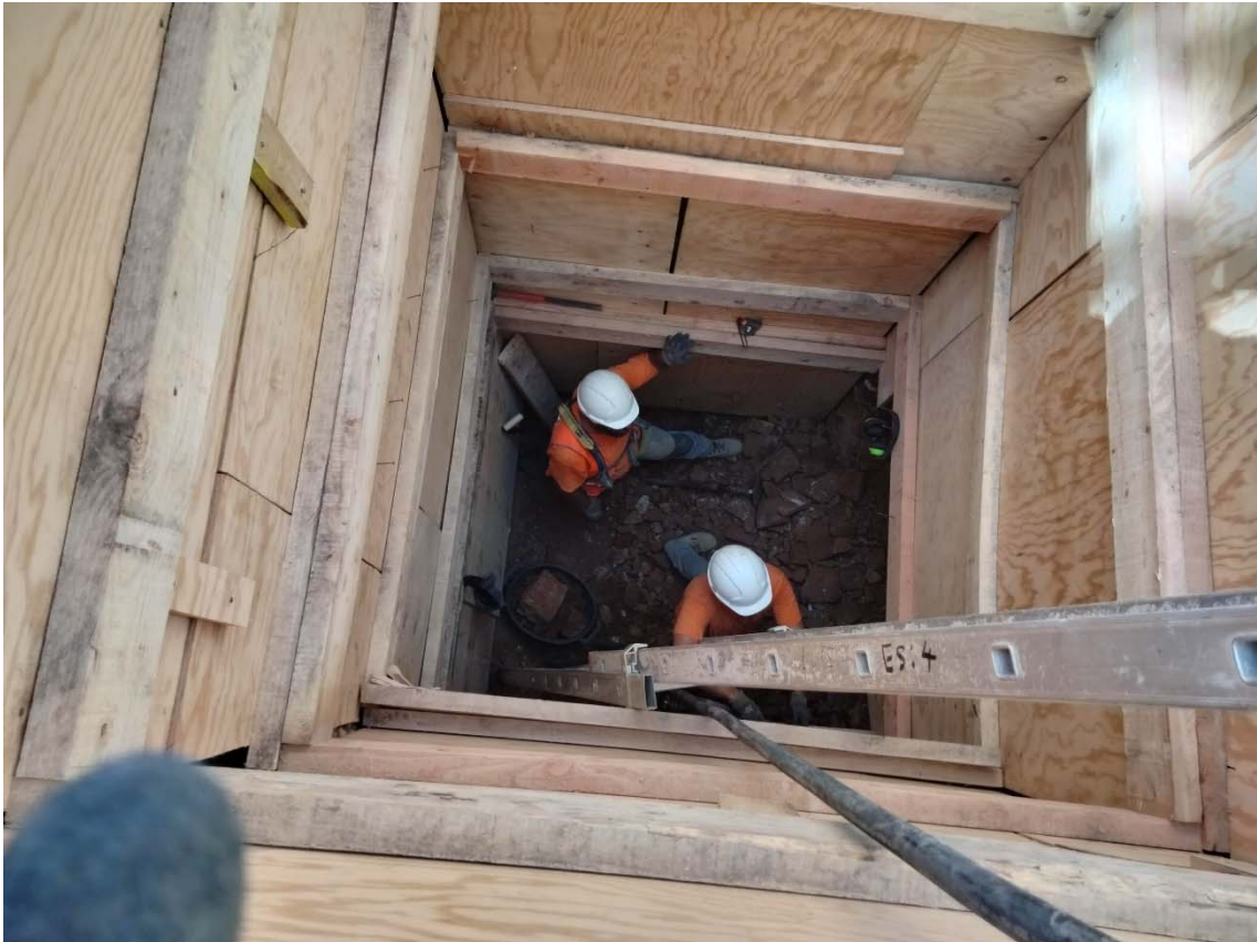
117. Procés d'excavació de la UE 6 al Pou 2.
