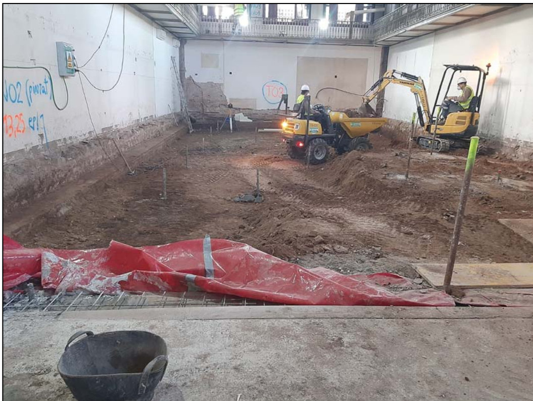
6. Actuacions de rebaix de l'ala nord de la planta baixa.
