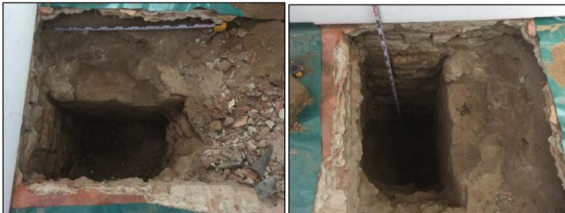
Vista de la UE 107 22 i la fonamentació oest de l'edifici.
