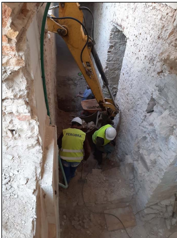
59. Àmbit C. Tasques de realització del fossat de l'ascensor.
