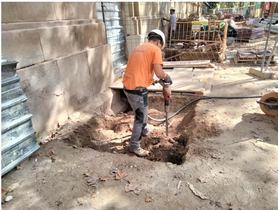
124. Inici excavació del Pou 3 adjacent a la façana del Museu.
