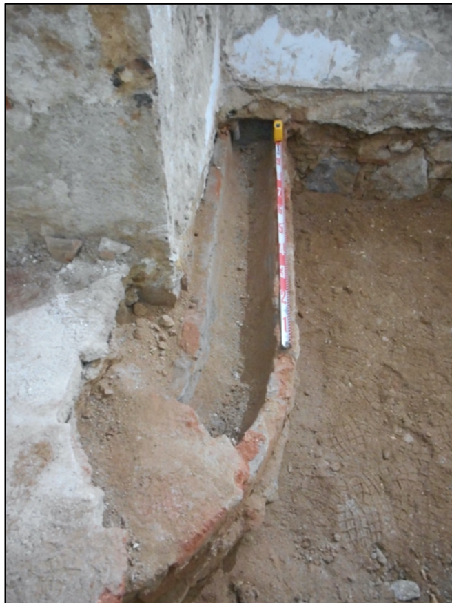
21. Localització d'un traçat de clavegueram UE104, àmbit A.
